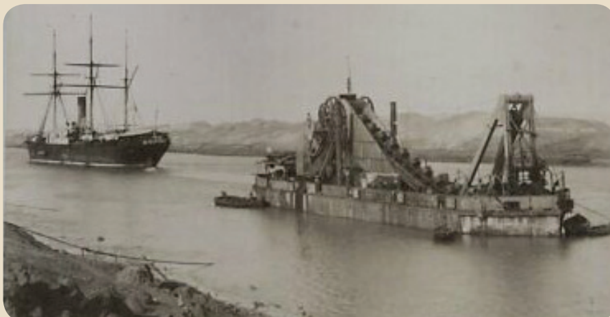
كراكات أثناء عملها بالقناة قبل التأميم
